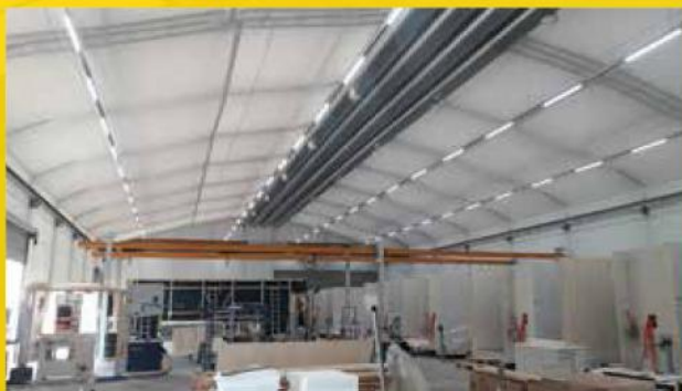
Производствено хале с вътрешна мембрана
